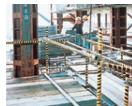
工事現場の事故防止に
