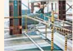
工事現場の事故防止に
