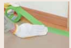
床面の養生に
