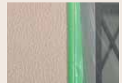
屋内外の塗装養生に
