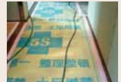
床養生シートの固定に
